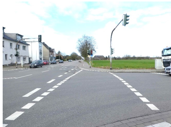
Foto 8: dito mit Blick gen Nordwesten
