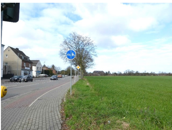
Foto 9: Blick entlang Dinslakener Str. gen Nordwesten mit Fuß- und Radweg neben dem Plangebiet und ...
