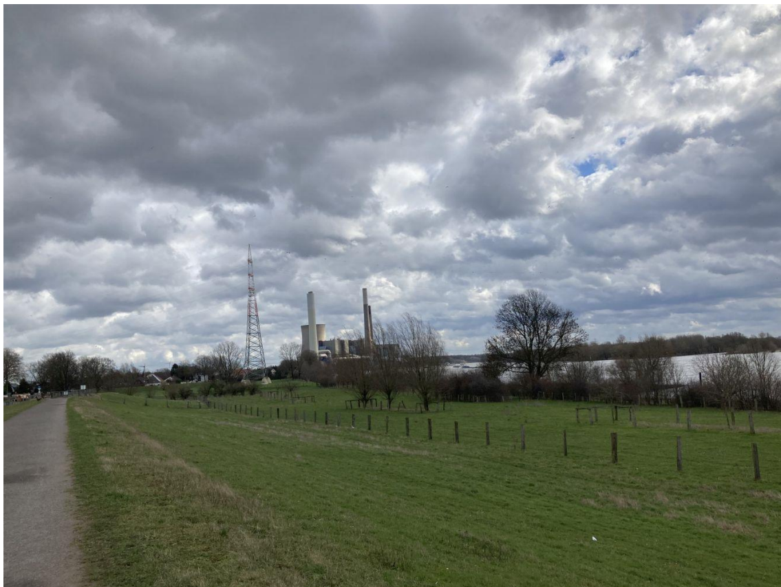
Abb. 21 Blick von Westen auf den Geltungsbereich (vor Sprengung des Kühlturms).
