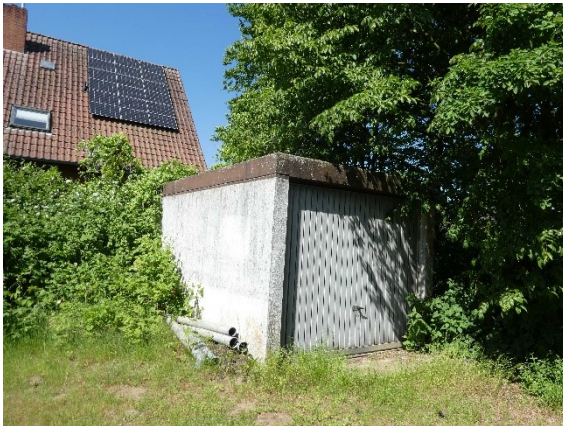
Foto 3: Rasen und Garage (geplante Zufahrt Ost)
