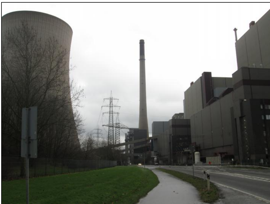
Abbildung 10: Steinkohlekraftwerk STEAG in Voerde
