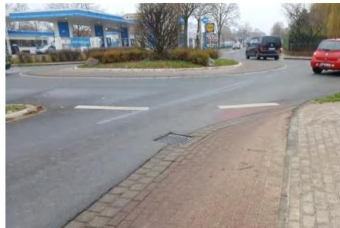
Abb. 3.6-6 Radwegeführung am Kreisverkehr,
