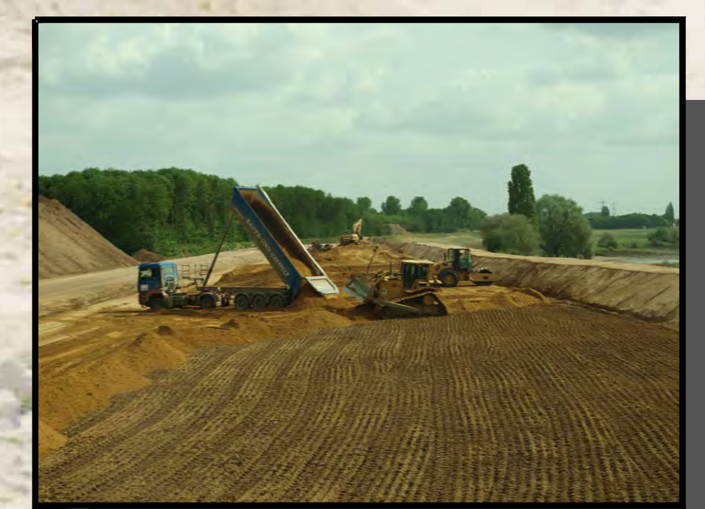
Herstellung Stützkörper
