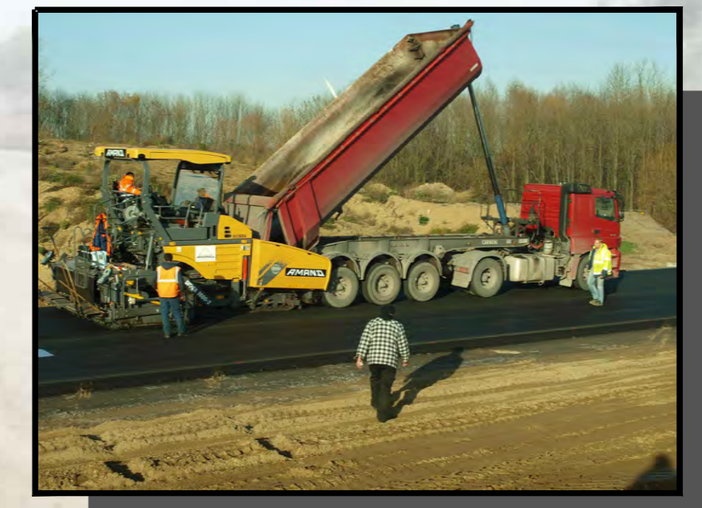
Neubau der L4 (Dammstraße)
