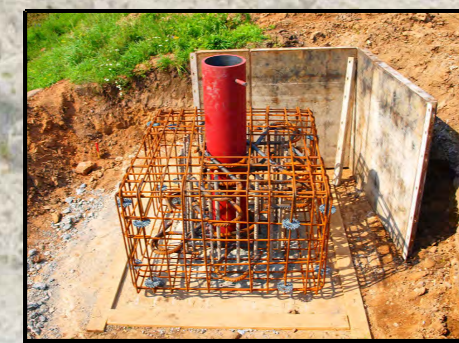
Bewehrungsarbeiten Festmachereinrichtung
